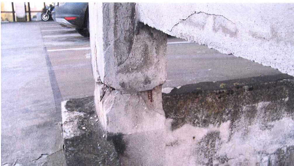
Fot. 7. Nawierzchnia podjazdu przylegająca do ściany budynku „B”. Widoczny zły stan nawierzchni oraz lica ściany i cokołu.
