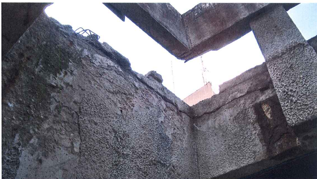
Fot. 4 - 6. Podjazd do budynku MIR. Zniszczone krawężniki w sąsiedztwie schodów.
