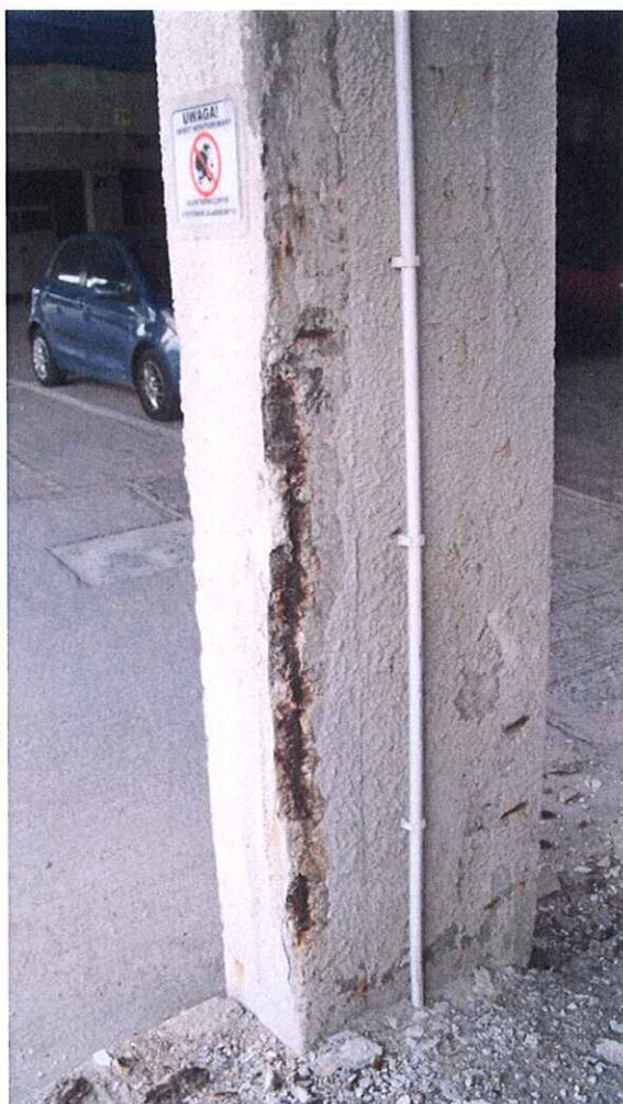
Fot. 26,27. Północny słup ramy, odpadła otulina pręta głównego, stal silnie skorodowana.
