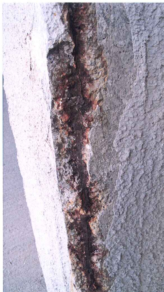
Fot. 26,27. Północny słup ramy, odpadła otulina pręta głównego, stal silnie skorodowana.
