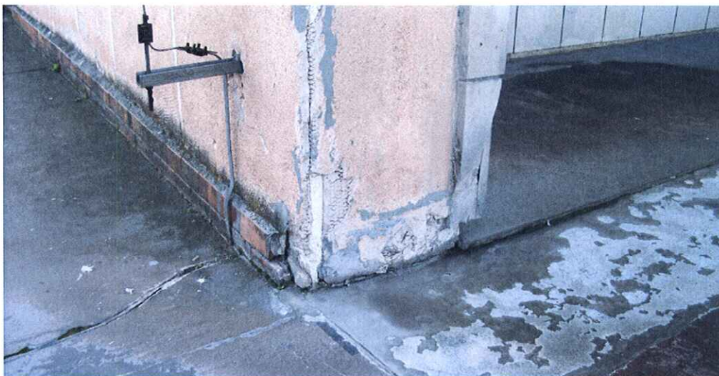
Fot. 7. Nawierzchnia podjazdu przylegająca do ściany budynku „B”. Widoczny zły stan nawierzchni oraz lica ściany i cokołu.
