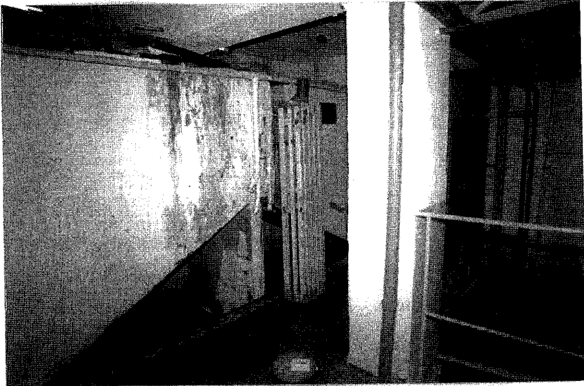
Fot. 19. Zbiorniki na wodę w sąsiedztwie słupa w osi „3”. Widoczna korozja ścian zbiornika.
